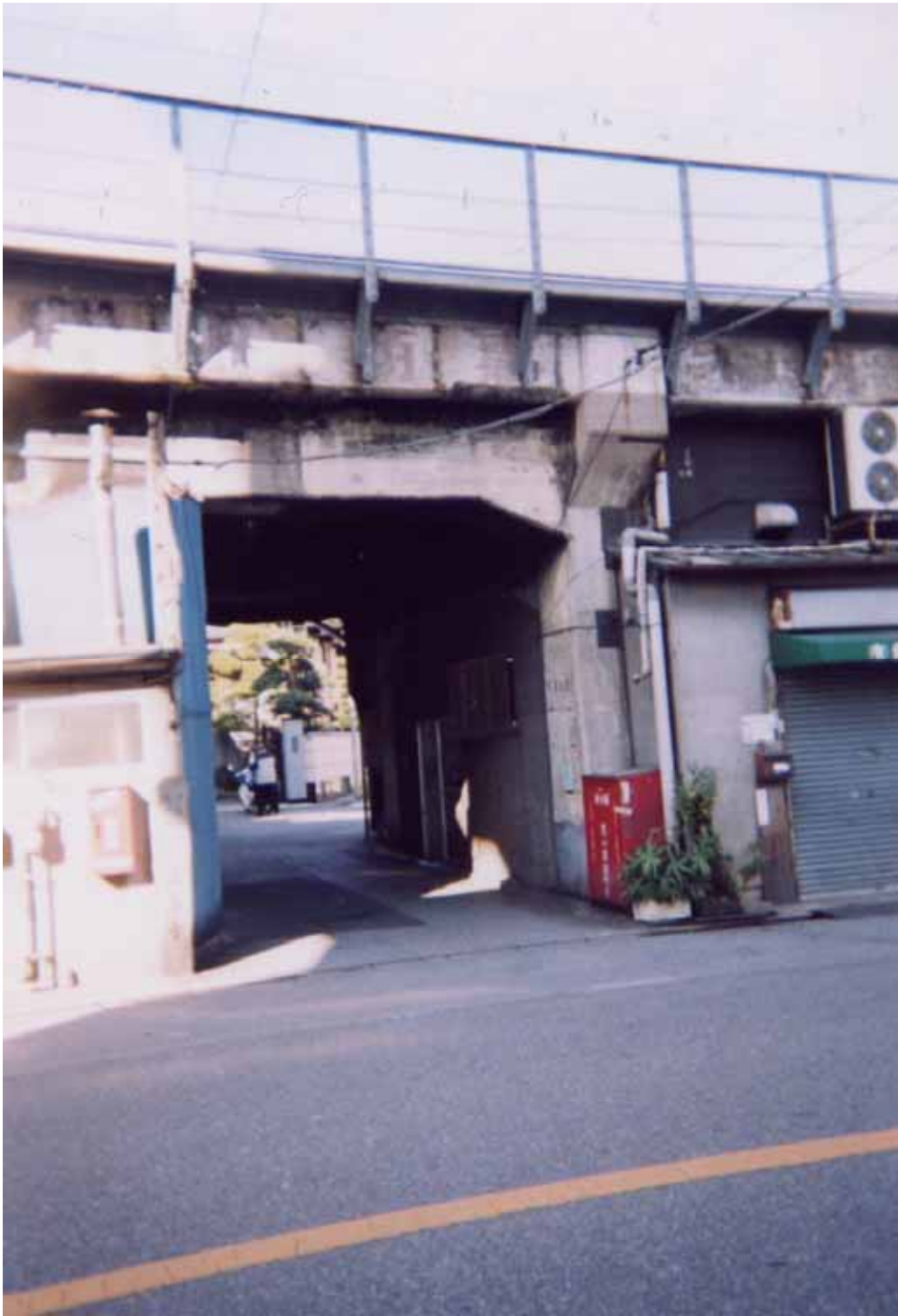
写真 1 - 4 - 2 京成本線ガードの「細街路トンネル」
