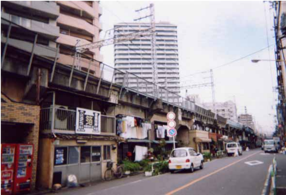
写真1 - 4 - 1 京成本線ガード（荒川7丁目、町屋駅前付近）
