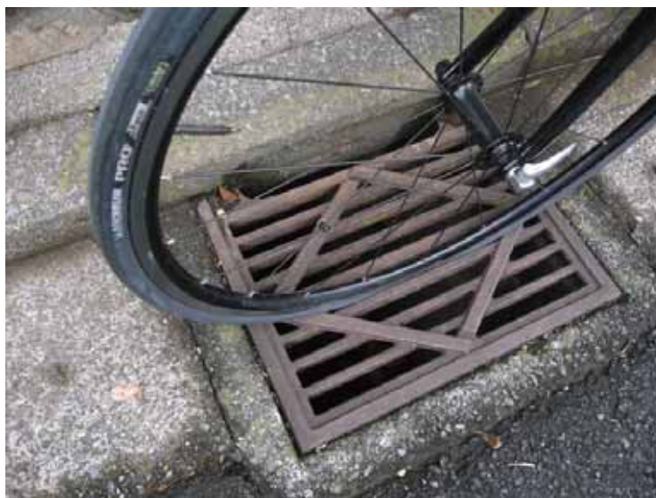
写真 14 横浜市内全域に存在する危険な側溝（2011年12月15日 自宅前にて筆者撮影）
