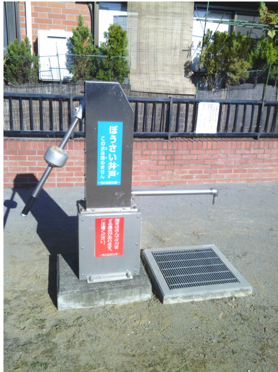
写真 3-4-4 二丁目防災広場の防災井戸
