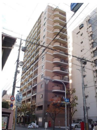
図 2-27 タワーマンション建設ラッシュ直前の平成 10 年頃に建設されたマンション
