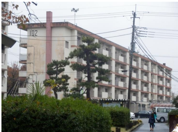
写真2-1 老朽化した豊四季台団地1
