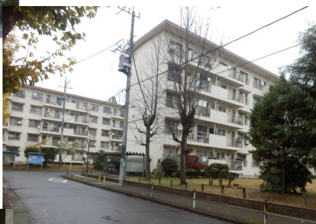
写真2-2 老朽化した豊四季台団地2
