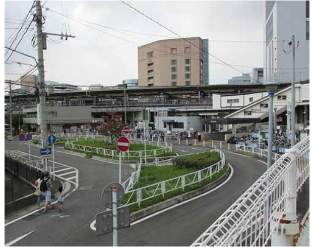
写真 1-10：新横浜駅篠原口広場
