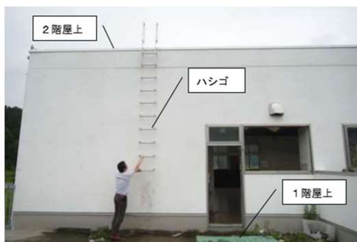
図 7 防災センター
